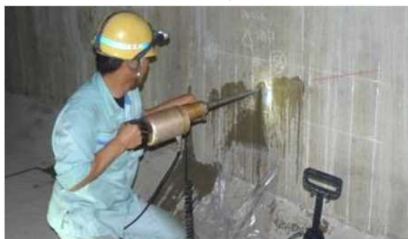
超音波ドリルによる削孔
