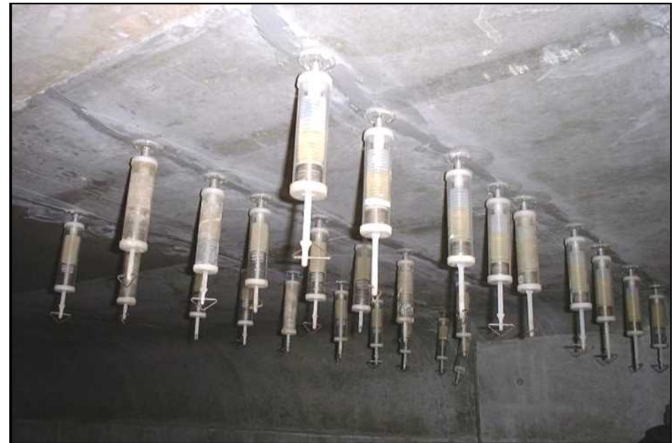
注入工法実施状況
