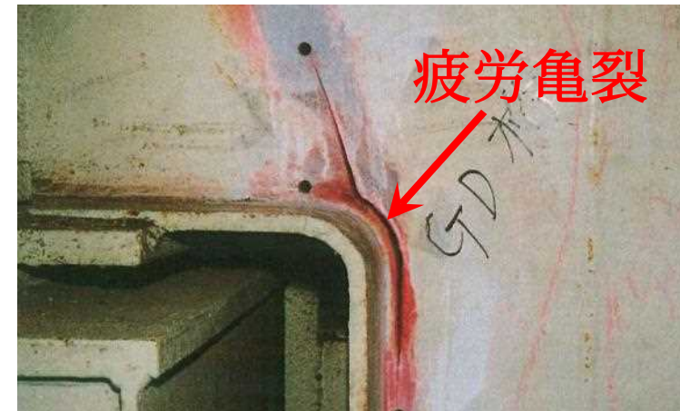
鋼桁切欠き部の疲労亀裂
