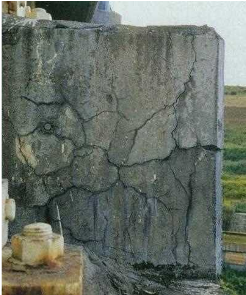
橋脚掛け違い部
