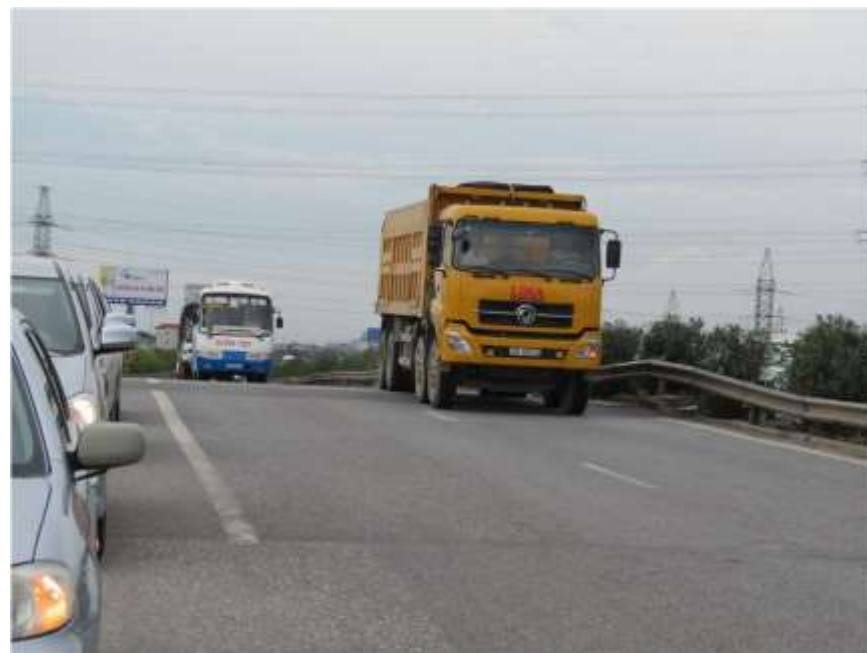
横断構造物付近の平坦性不良
