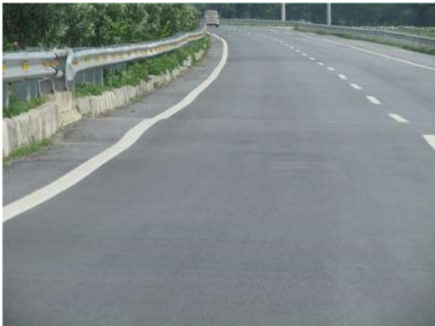
横断構造物付近の平坦性不良
